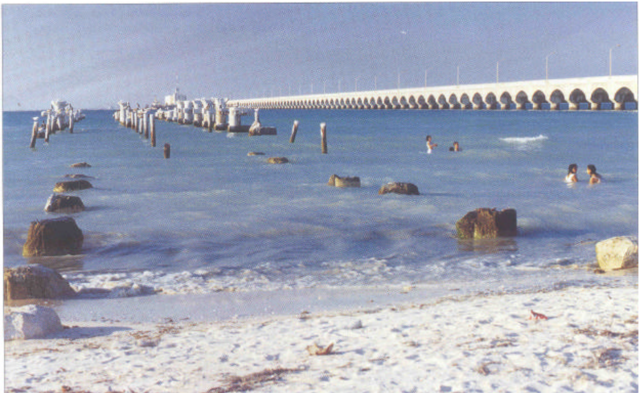
Fig.8 – Ponte costruito con cemento armato con tondino inox a confronto con pontile costruito con cemento armato tradizionale: il ponte è stato realizzato dieci anni prima del pontile
