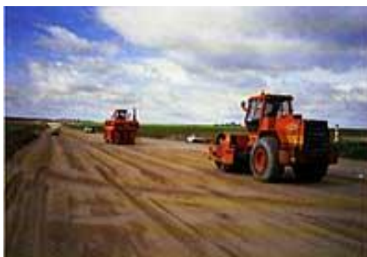
Figura 4.7- GBS nella costruzione di strade [10].
