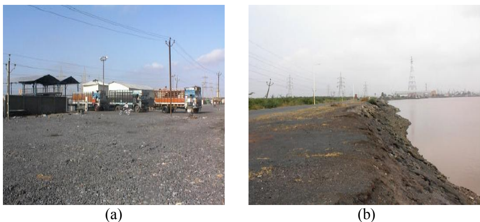
Figura 4.19- a)Substrato di scorie da EAF in parcheggio per mezzi pesanti, b) argine di protezione della costa marina fatto con scorie da EAF [15].
